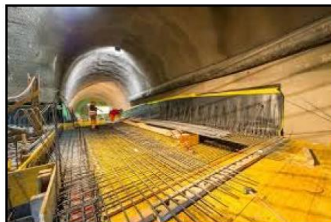
Fig. 4. 7. Fouilles en pleine masse
