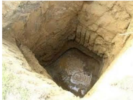
Fig. 4. 5. Fouilles en puits
