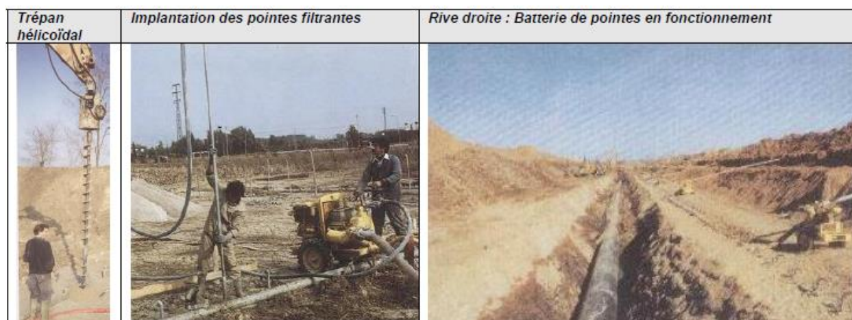
Fig.5. 11. Rabattement des nappes au fond de fouille
