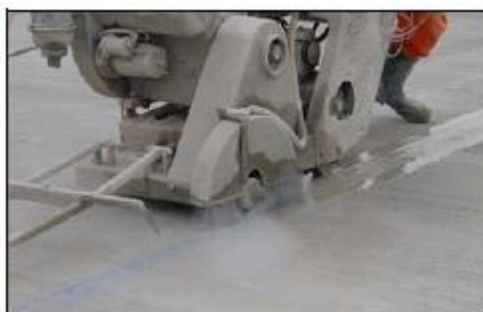
Fig.5. 1. Découpage soigné du revêtement par une scie
