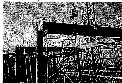
Mise en œuvre de poutres préfabriquées
