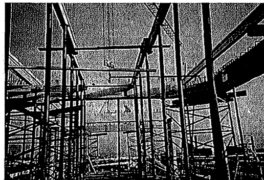
Étalement pour la mise en place des prédalles.
