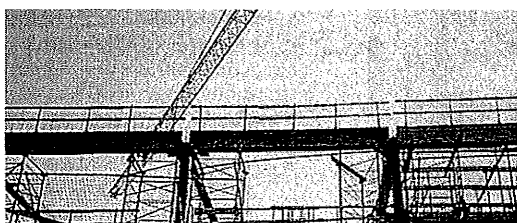
Poutres alignées en rive
