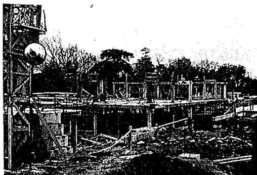
Vue d'ensemble : structure poteaux-plancher
