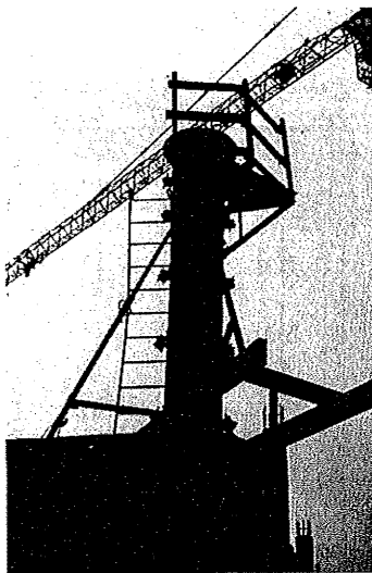
Coffrage d'un poteau de section circulaire
