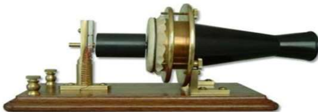
Figure I.8 : Le premier modèle de Téléphone de Graham Bell
