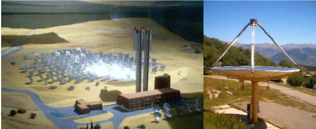
Figure 3.18: champ d'héliostat -centrale solaire Thémis France.
