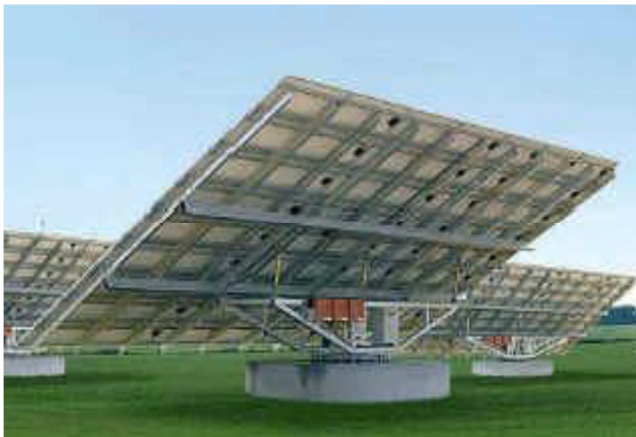
Figure 3.25: Suiveur à 1axe vertical incliné.
