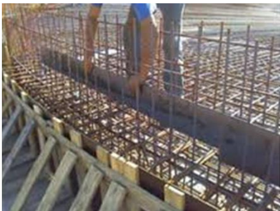
Figure III. 21. Ferrailage et coffrage d'un voile du radier d'un réservoir de forme rectangulaire.
