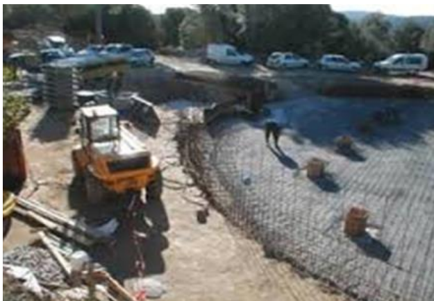
Figure III. 20. Ferrailage du radier d'un réservoir de forme circulaire
