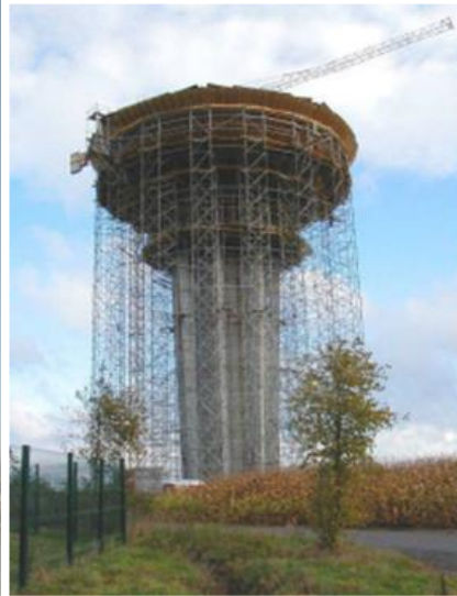
Figure III. 19. Coffrage de la cuve d'un château d'eau
