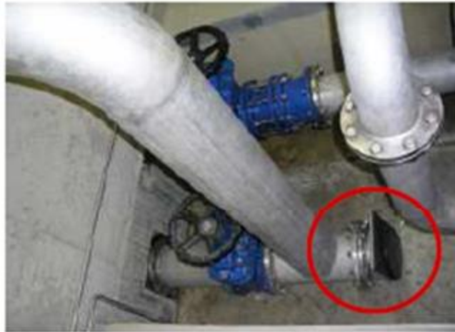
Figure III. 13. Trop-plein muni d'un clapet non-retour
