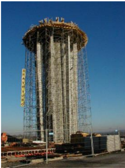
Figure III. 19. Coffrage de la cuve d'un château d'eau
