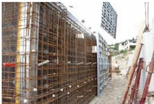
Figure III. 21. Ferrailage et coffrage d'un voile du radier d'un réservoir de forme rectangulaire.
