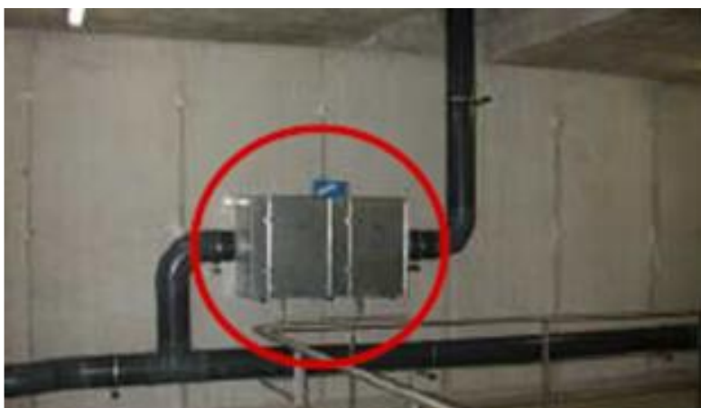
Figure III. 16. Système d'aération muni d'un filtre d'air
