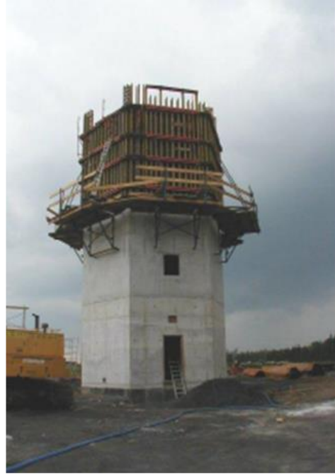
Figure III. 18. Coffrage glissant – fût d'un château d'eau
