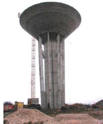
Figure III. 19. Coffrage de la cuve d'un château d'eau
