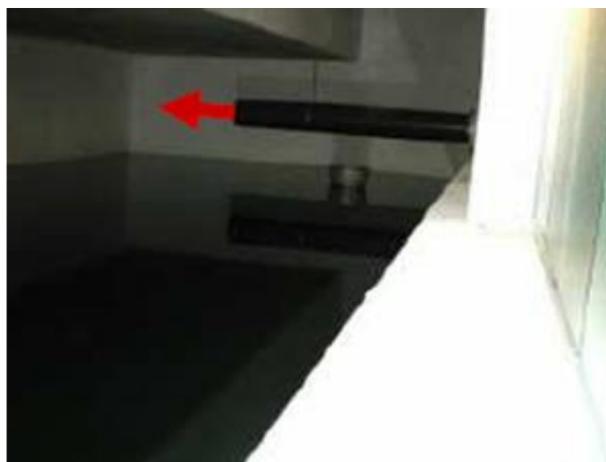
Figure III. 17. Gaine d'aération horizontale avec légère contrepente
