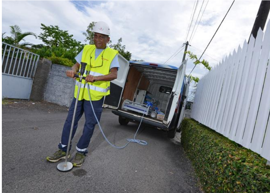
Figure V. 11. Corrélation acoustique pour recherche des fuites d'eau ( https://www.zinfos974.com )
