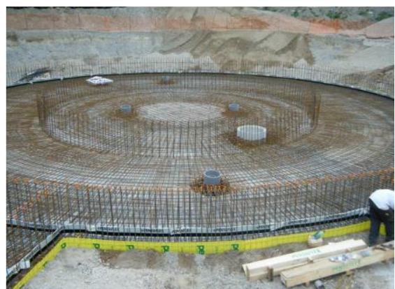
Figure III. 20. Ferrailage du radier d'un réservoir de forme circulaire
