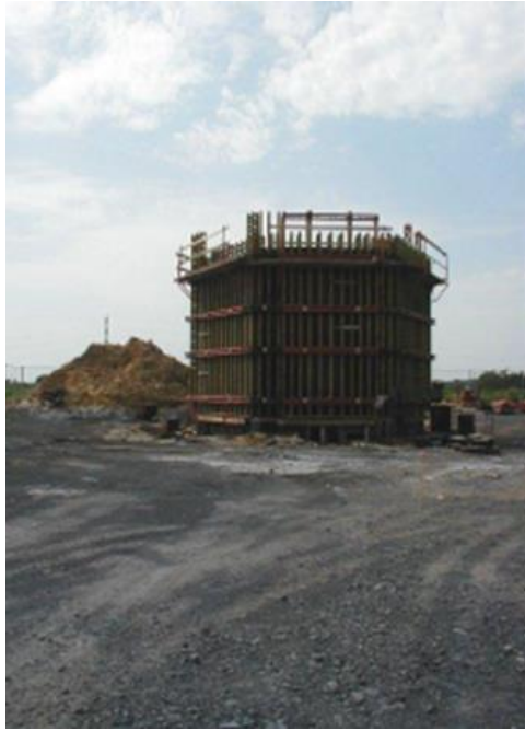
Figure III. 18. Coffrage glissant – fût d'un château d'eau
